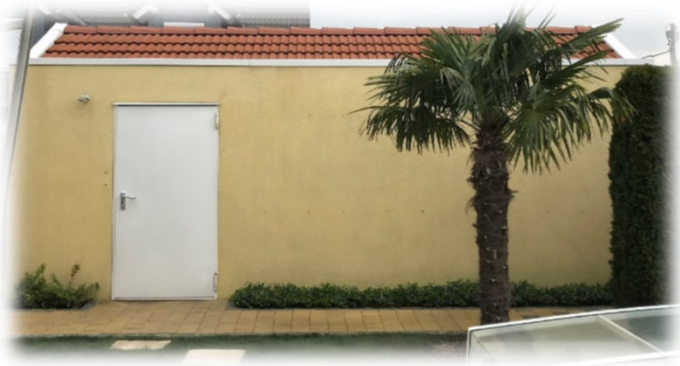
Hauswand im Poolbereich
